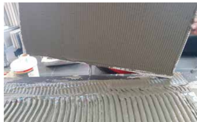
Obr. 8 – Lepení metodou buttering-floating
