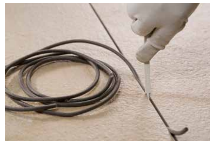
Obr. 29 – Separací provazec
