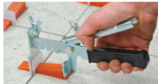
Obr. 6 – Vyrovnávací klínky
