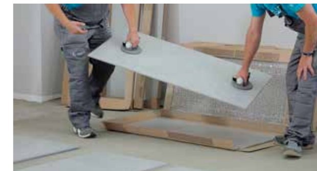
Obr. 7 – Přísavky na velké formáty
