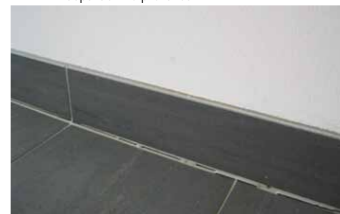
Obr. 31 – Potrhaná dilatační spára bez použití separačního provazce
